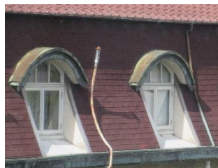
ドーマー窓と半円形屋根
