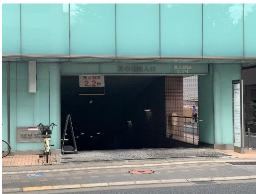
地下駐車場入口スロープ正面
