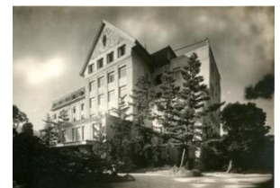
開業当時の外観
