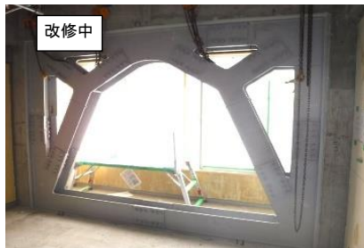
鉄骨マンサードブレース
