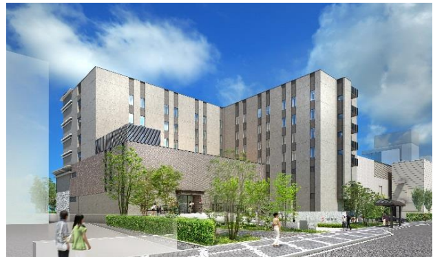
<外観:松江しんじ湖温泉駅側入口(北側)>
