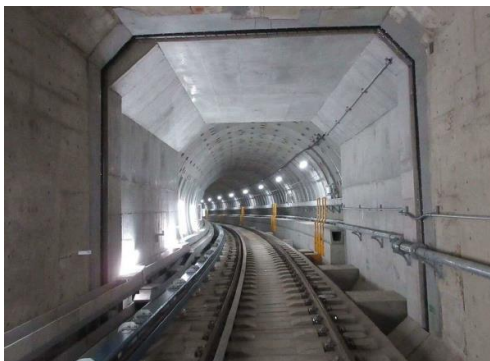
トンネル接続部
