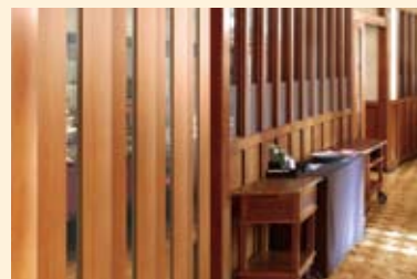
鉄板コーナー扉新設
